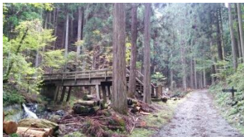
東屋からの景色は good (S:4,21km,A,B:4 km)
